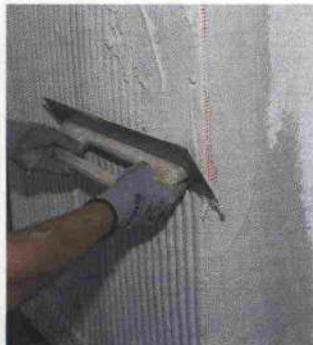
Sistema d'isolamento termico a cappotto in grado di assicurare la riduzione dei consumi energetici estivi e invernali, e aumentare il comfort abitativo. La corretta coibentazione di un edificio deve consentire il mantenimento della giusta temperatura dell'aria e della struttura impedendo il trasferimento di calore, sia
