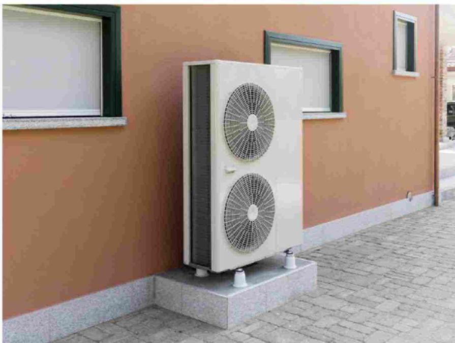
Nel circuito delle pompe di calore è presente un fluido refrigerante che cambia stato: da liquido si trasforma in vapore e viceversa, attraverso la sinergia di un compressore, un condensatore, una valvola di espansione e infine vi è un evaporatore.
