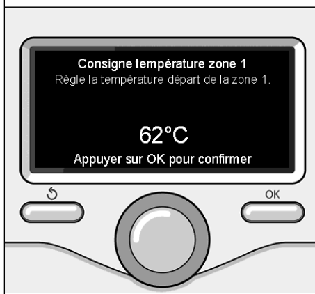
Modifier température eau chaude chauffage
